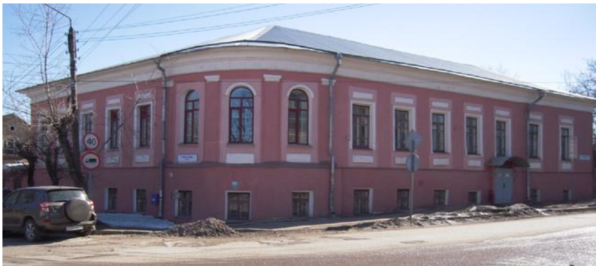
«Дом Окулова, 1795 г., арх. Росляков Ф.М.», расположенный по адресу: г. Киров, ул. Казанская, 52
